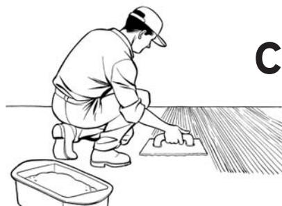
**C** Nivelar el suelo con pasta niveladora. Colocar el cemento cola sobre el suelo, con llana dentada, con un espesor aproximado de 10 mm.
